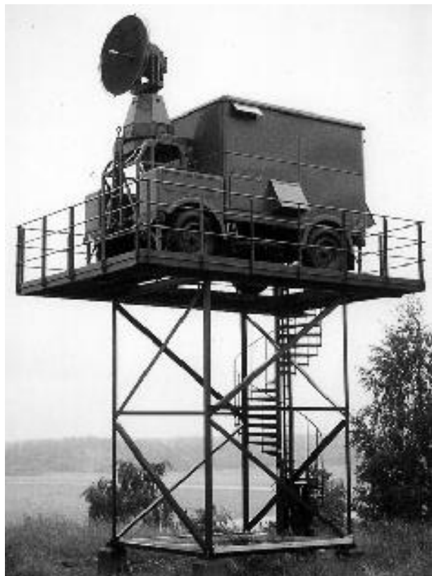
PV-30 stationerna var fast monterade på ståltorn. Det fanns också mobila enheter. Bilden visar en sådan som har lyfts upp på ett ståltorn – avancerad fickparkering!
