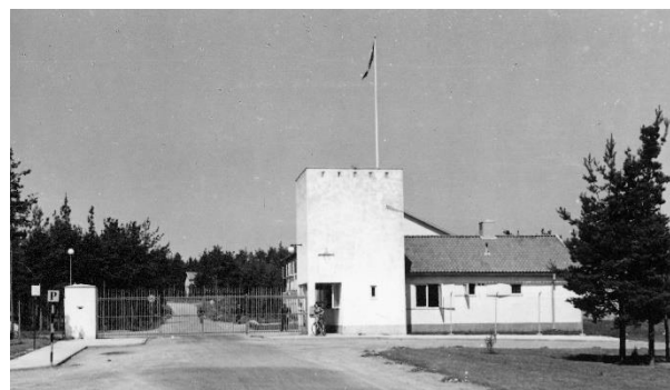
Vakt och arrestbyggnad
