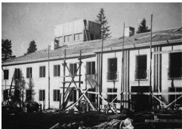
Kanslihus med flygledartorn på taket
