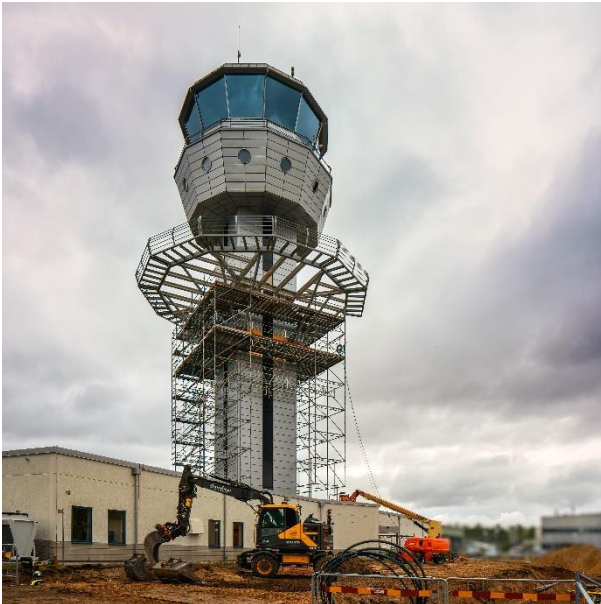
Stålkonstruktionen till väderavdelningen är på plats
