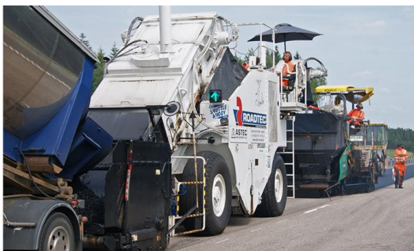
Lastbilen t v fyller den vita Shuttle buggy:n som förser den gröna läggaren t h med asfalt. Foto Peab
