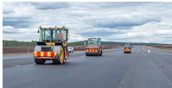
Typbild av vältning/packning av rullbana Foto Peab
