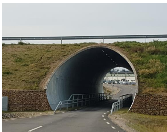
Ny väg med 50 m lång rörbro under den nya taxibanan.
