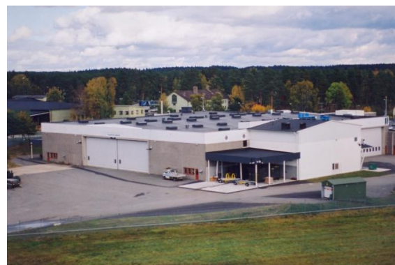
En from förhoppning att den tillbyggda blästrings- och målarverkstaden får leva vidare på F 17.
