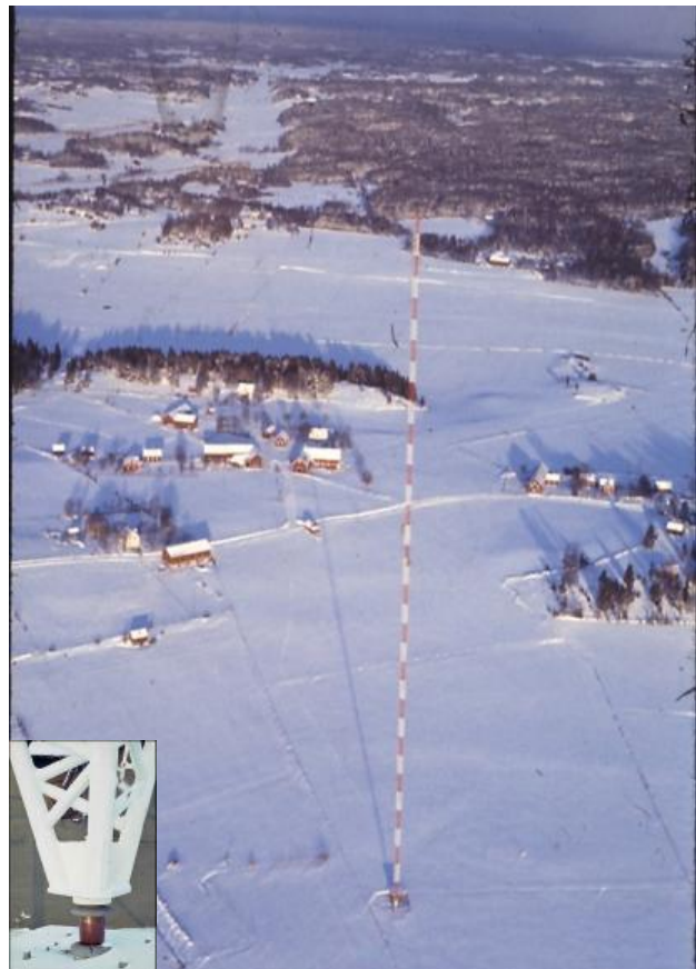
Radiomast/antennfot RT 02 grupperad i Roslags-Bro
