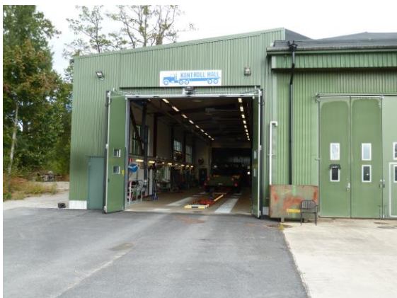
Den nya kontrollhallen.
