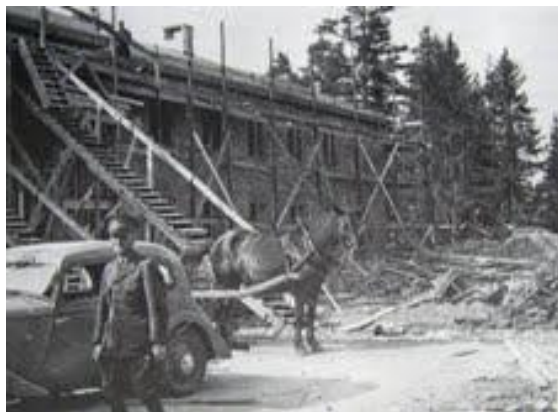
Kn Klingström övervakar matsalsbygget
