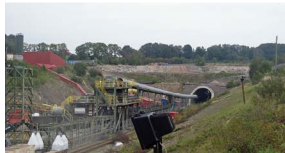
Nuvarande huvudarbetsplats vid Förslöv, tunnelns södra ingång.
