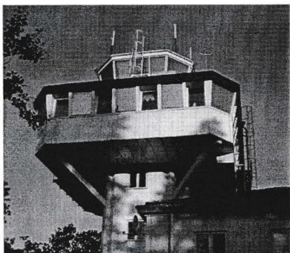
F17 väderavdelning i nya lokaler, tillbyggnaden under trafikledartornet, inflyttning september 1982
