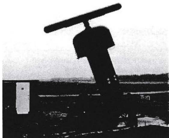
Navigerings- och landningsradar (GCA), under uppmontering
