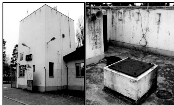
Pjäsfundament för 20 mm lvakan på taket till F 17 vakt
