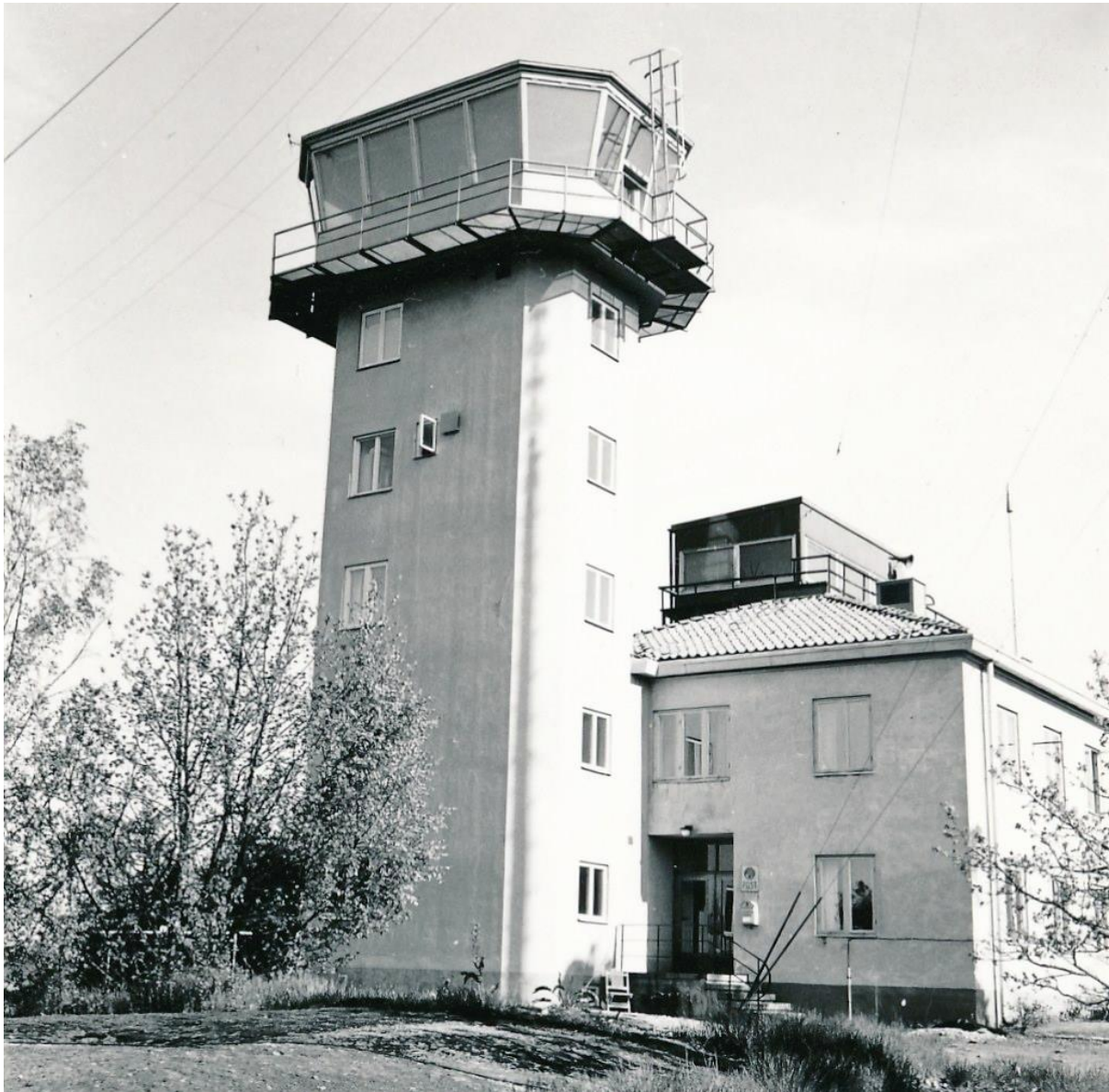
Postskylt och brevlåda sitter till höger om dörren på kanslihusets södra gavel. På kanslihustaket syns det ursprungliga flygledartornet från 1947.
