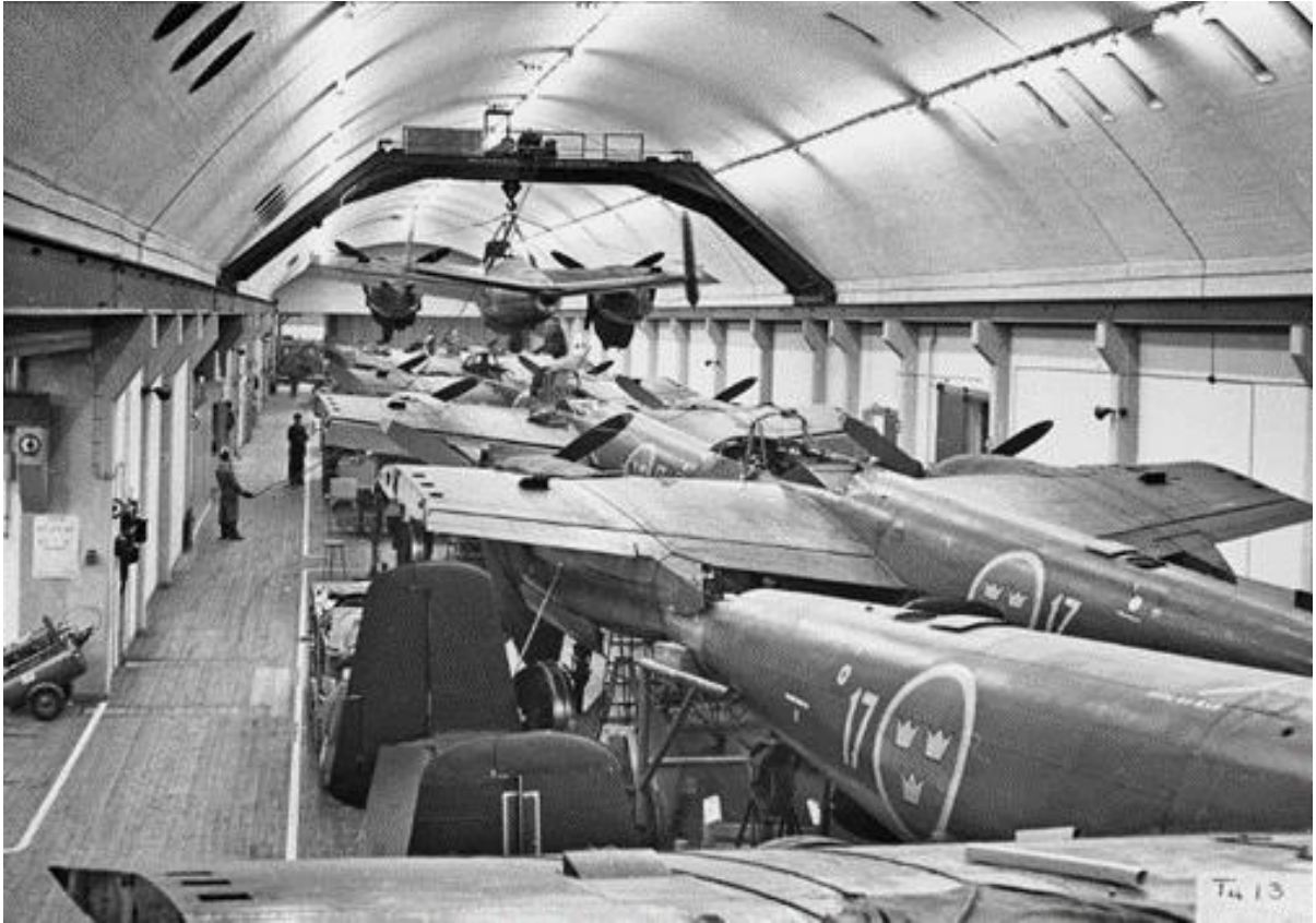
T 18 på SAAB för modifiering av stjärtpartiet
