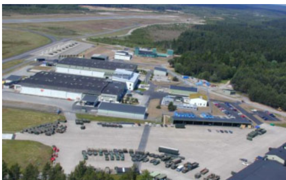
I samband med ombeväpningen till JAS 39 skedde en omfattande nybyggnation och JAS anpassning. De båda 37-hangerna sammanbyggdes till H 47.
