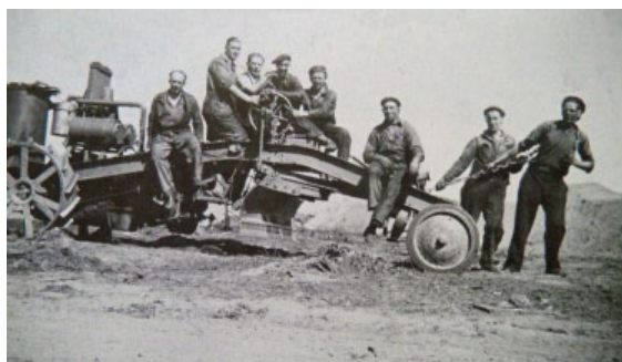
Flygfältet byggs med bl a gengasdriven väghyvel.
