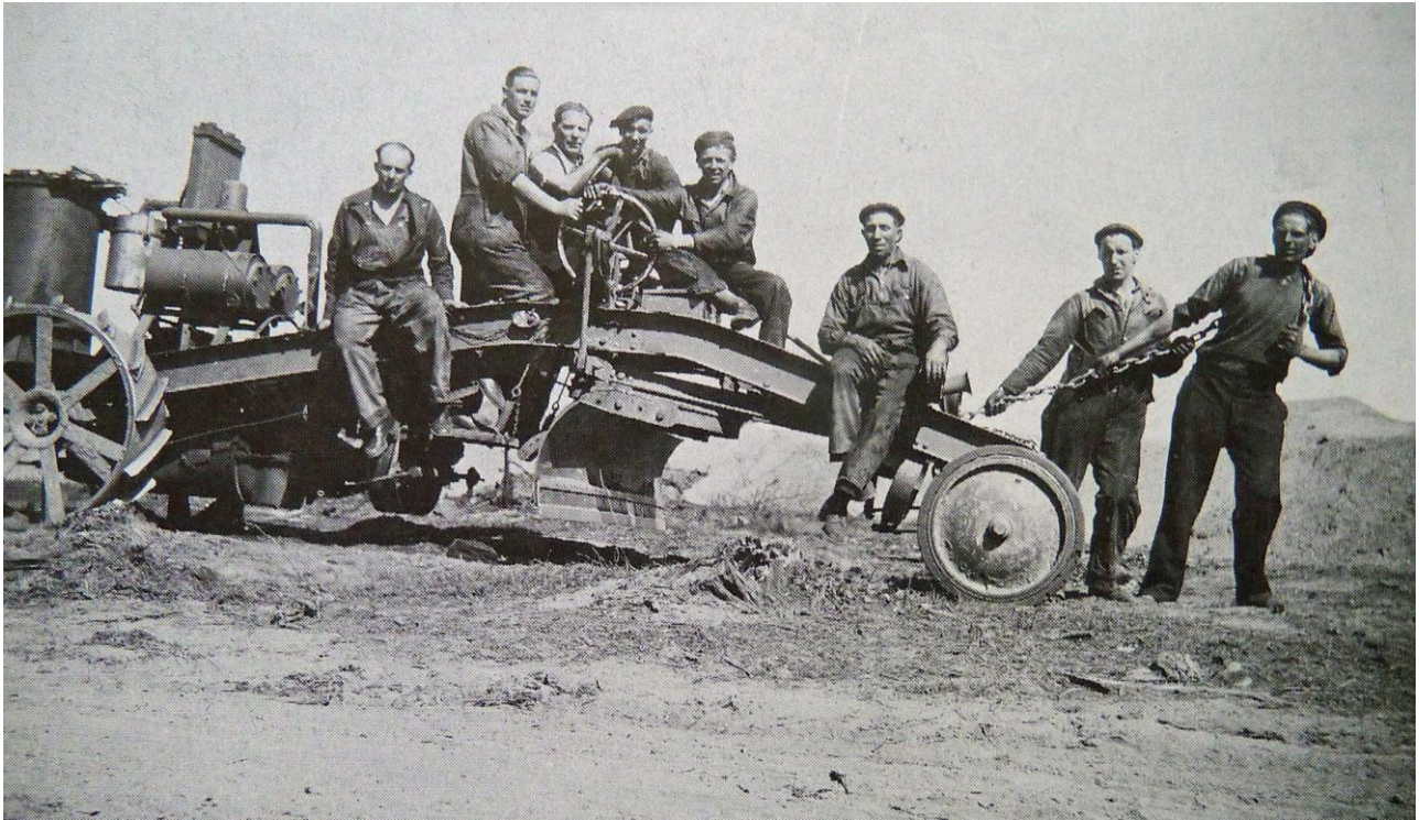
Gengasdriven väghyvel som användes vid utbyggnaden av fältområdet på F17
