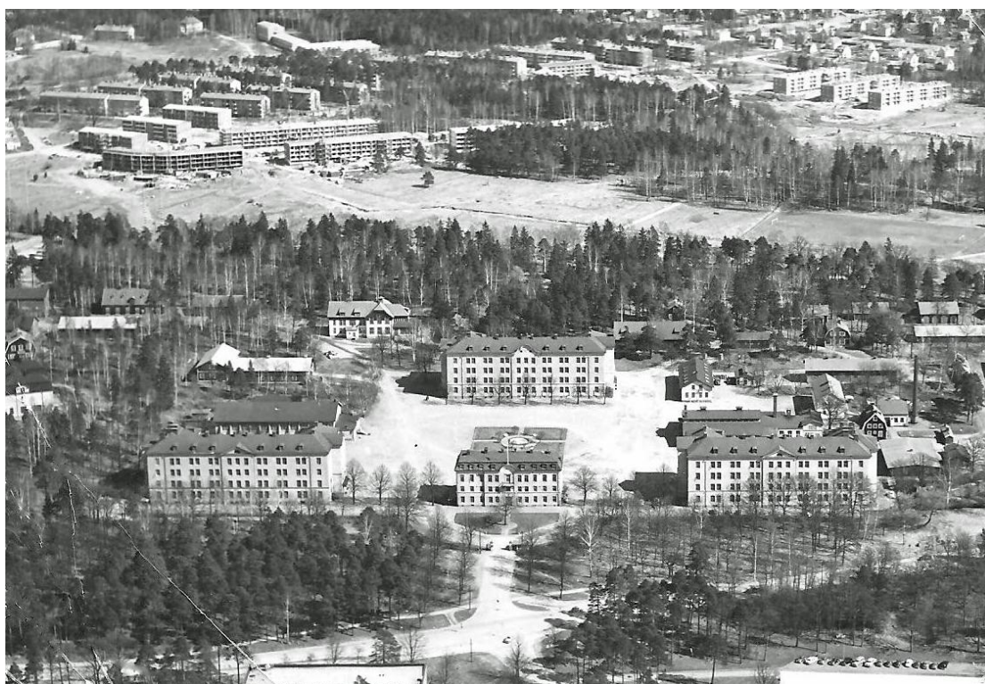
Flygvapnets centrala skolor, FCS, i Viksäng, Västerås. Byggnaden i mitten på andra sidan kaserngården är FSS, där signalistutbildningen ägde rum till i början av 1960-talet, då utbildningen flyttades till F14 i Halmstad.
