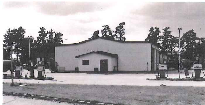
Flottiljens tankningsanläggning för fordon
