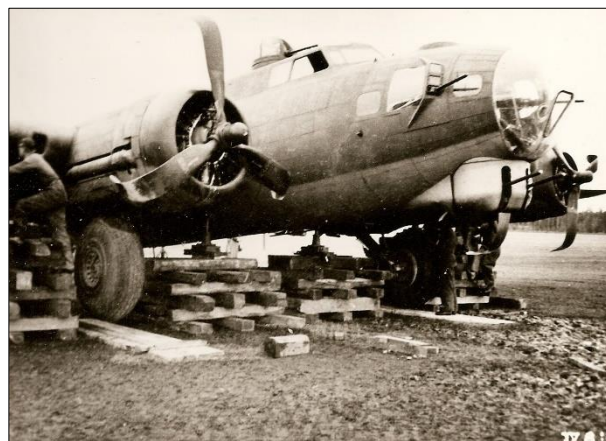
Uppallad och hjulen på väg ut. Propellrar böjda. Motor- och propellerbyten påbörjade
