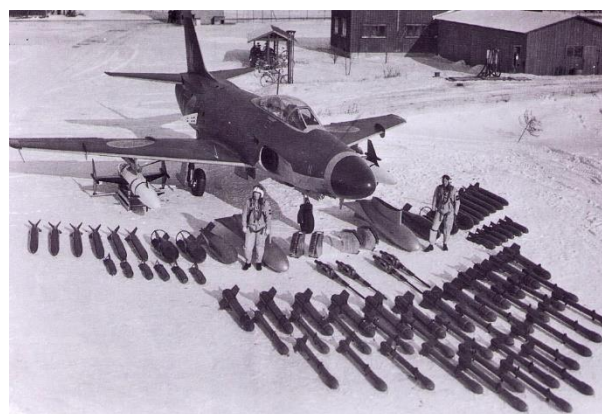
Bilden visar den mängd av olika vapentyper som kunde bäras av A 32. Fyra fast monterade 20mm akan i nosen. Bomber, raketer och sjömålsrobot Rb04 i balkar under vingarna i olika lastalternativ beroende på typ av mål.
